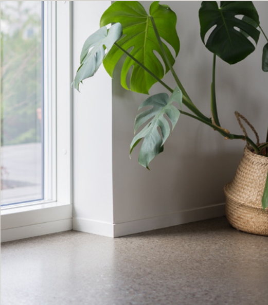
↑ Silverslipat betonggolv i entréplan.
