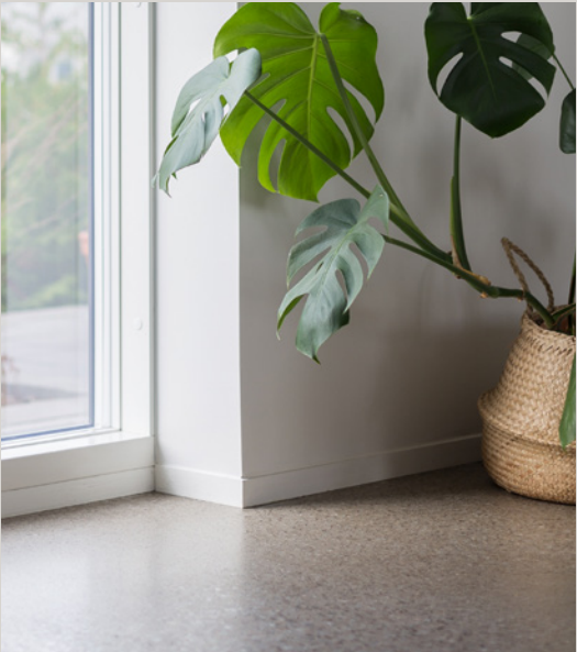
↑ Silverslipat betonggolv i entréplan.
