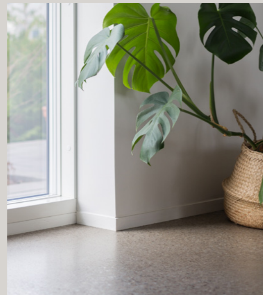
↑ Silverslipat betonggolv i entréplan.
